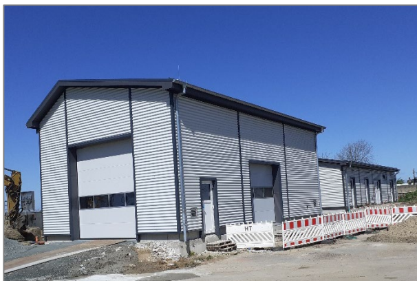
Neues Betriebsgebäude und Rechenhalle
