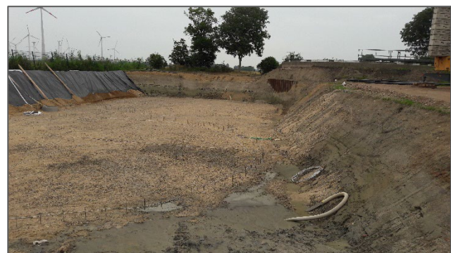
Baugrube für SBR-Behälter
