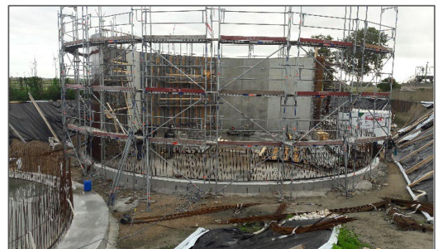
Bau des SBR-Behälter
